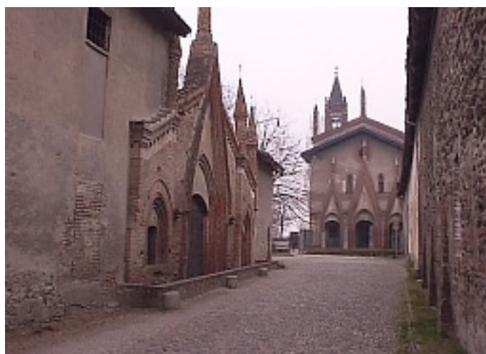
Sullo sfondo la Torre Buschera DCI-TO434
